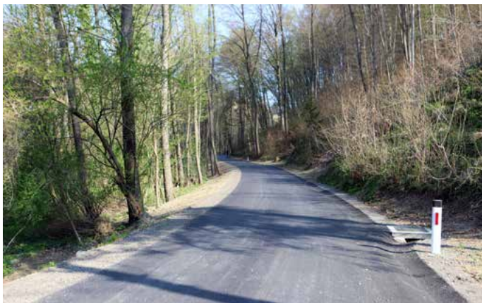
Rekonstrukcija ceste v Svečanah
